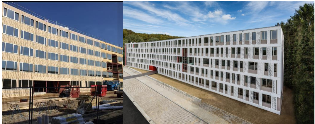
Abb. 6: Fertigstellung Modulplatzierung und fertiges Objekt (Facebook 06.10.2016)
