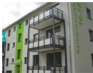
Abb. 49: Gebäude nach Sanierung
