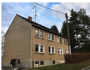
Abb. 39: Gebäude vor Sanierung mit Wärmepumpen-Außenluft-Einheit
