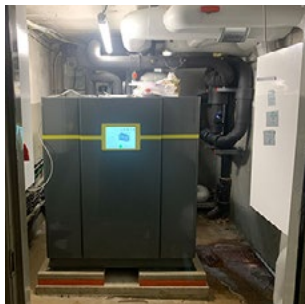
Abb. 57: Wärmepumpe
