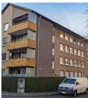
Abb. 65: Gebäude vor der Sanierung
