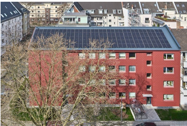
Abb. 28: Vogelperspektive auf das Projektgebäude: Nach der seriellen Sanierung erzeugt das Gebäude 20 % mehr Solarstrom, als die Bewohnenden benötigen.
