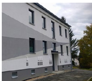
Abb. 38: Dezentrale Lüftungseinheiten integriert in Dämmelemente
