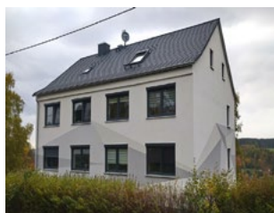
Abb. 40: Gebäude nach Sanierung
