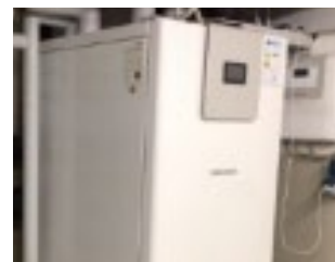
Abb. 51: Visualisierung Anordnung Wärmepumpen und Speicher im Kellerraum
