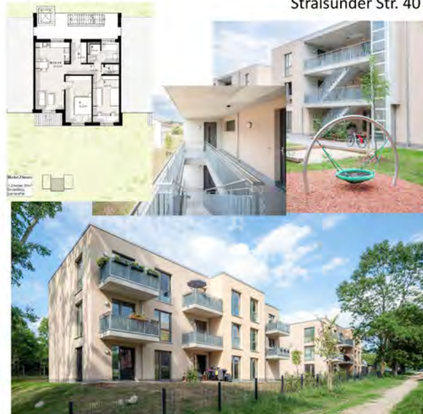
Bildquelle: gbg Wohnungsbaugesellschaft Hildesheim AG; Weber Massivhaus GmbH
