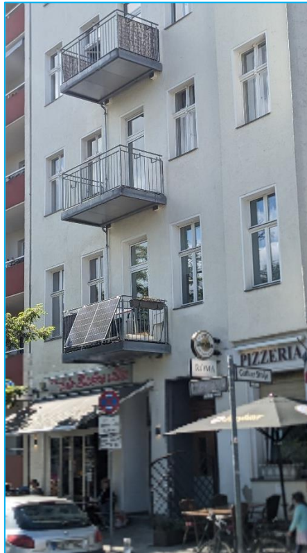
Abbildung 1: Eine Balkon-PV-Anlage, im 45 Grad-Winkel montiert (Quelle: GdW)
